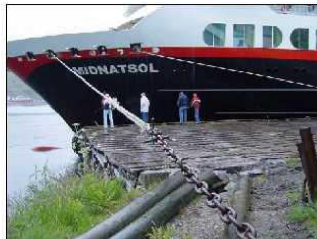
I 2003 var en del av kaien fortsatt av trevirke. Legg merke til den noe spesielle fortøyningen.
